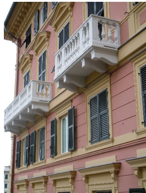
Thermisch verzinkte, met staal versterkte betonnen steunbalken voor de balkons van een elegant appartement in Genua. Er werd gekozen voor verzinkt betonstaal om de draagbalken van de balkons zo goed mogelijk te beschermen tegen smog, regen, vorst en vocht. (Afbeeldingen met dank aan Prefabbricati Torti di Pietro e Lino Torti snc)
