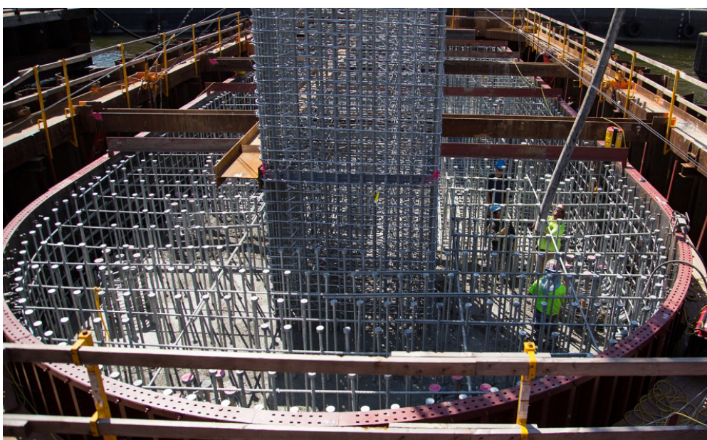
De 43 paar betonnen pijlers van de Mario M. Cuomo brug worden versterkt door korven van verzinkt wapeningsstaal.
