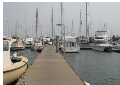
De drijvende pontons in de jachthaven van Sandringham, Victoria (Australië) maakten gebruik van thermisch verzinkte versterking
