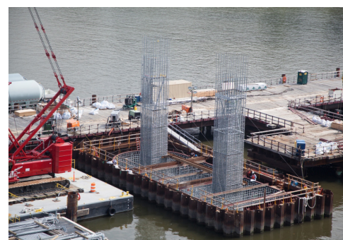
Meer dan 27.000 ton verzinkt betonstaal zorgt voor de lange termijn duurzaamheid van de torens van de hoofdoverspanning, de pijlers van de aanloopoverspanning, de landhoofden en de wegdekpanelen van de Mario M. Cuomobrug.
