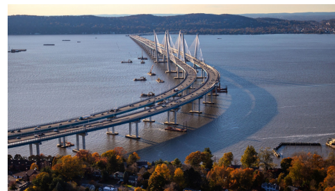
De onlangs voltooide Mario M. Cuomo brug was het grootste brugproject in de geschiedenis van de staat New York. De nieuwe brug verving de vorige Tappan Zee Brug over de Hudson ten noorden van New York City.
