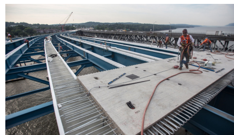
Het brugdek van de Mario M. Cuomo brug bestaat uit bijna 6000 prefab panelen, elk 3,66 m lang en 6,7-13,7 m breed, voor de toegangsoverspanningen en 963 dekpanelen voor de hoofdoverspanning. De panelen worden samengevoegd door beton rond de uitstekende thermisch verzinkte stalen wapening te gieten. (Afbeelding met dank aan de New York State Thruway Authority)
