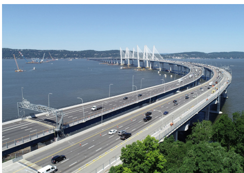
De Mario M. Cuomobrug is een 5 km lange, 8-baans tuibrug met twee overspanningen die ontworpen is voor een minimale levensduur van 100 jaar met gebruik van verzinkte wapening.
