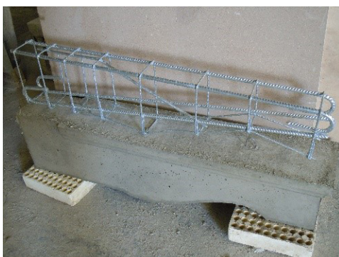
Thermisch verzinkte, met staal versterkte betonnen steunbalken voor de balkons van een elegant appartement in Genua. Er werd gekozen voor verzinkt betonstaal om de draagbalken van de balkons zo goed mogelijk te beschermen tegen smog, regen, vorst en vocht. (Afbeeldingen met dank aan Prefabbricati Torti di Pietro e Lino Torti snc)
