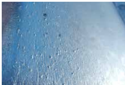
Exemple d'une repliure de laminage devenue visible après une galvanisation à chaud discontinue.
