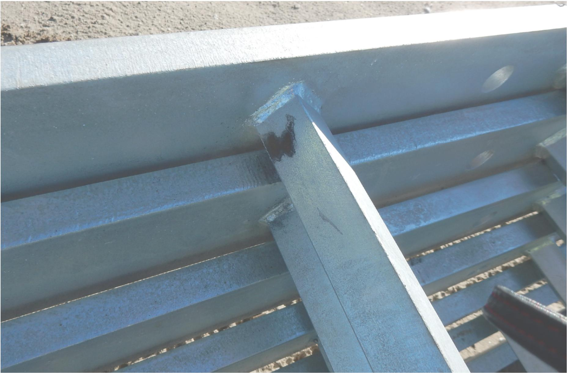
*Cette procédure de “retouche” s’applique aux zones qui ne sont pas galvanisées car elles ne réagissent pas avec le zinc fondu lors de l’immersion dans le bain de zinc. Il peut également être utilisé pour les objets galvanisés à chaud qui sont endommagés pendant le stockage, le transport, le montage ou à la suite d’un traitement mécanique.*
