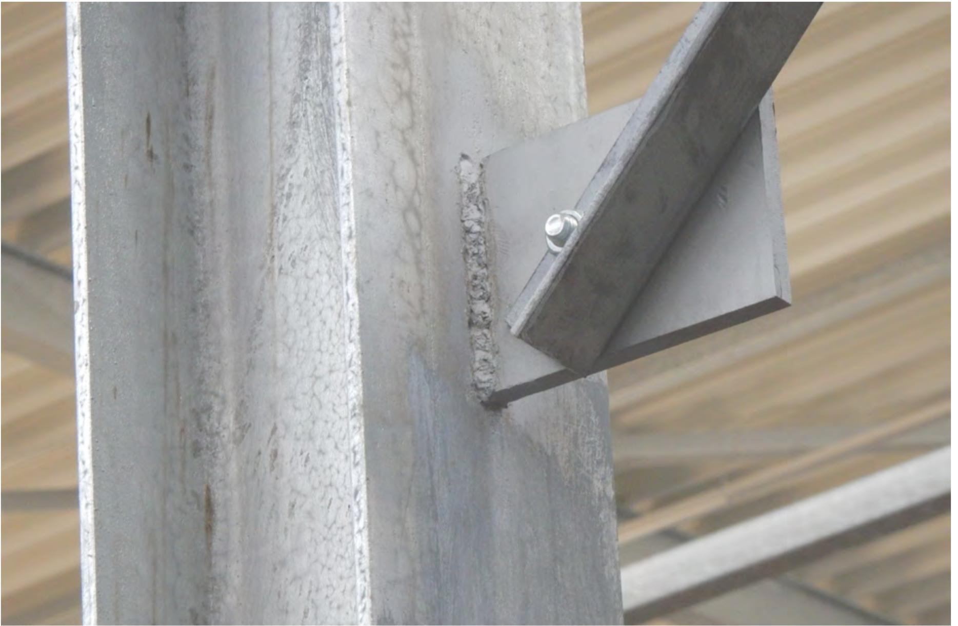
*Lors de la conception de structures importantes ou complexes, il est préférable d'utiliser des profilés droits et libres qui sont ensuite assemblés par des boulons. Plusieurs éléments de construction plats et lâches peuvent également être reliés après coup au moyen de boulons et d'écrous (galvanisés). Toutefois, si l'objet est si grand ou si compliqué qu'il doit être soudé après la galvanisation, un certain nombre d'éléments doivent être pris en compte.*
