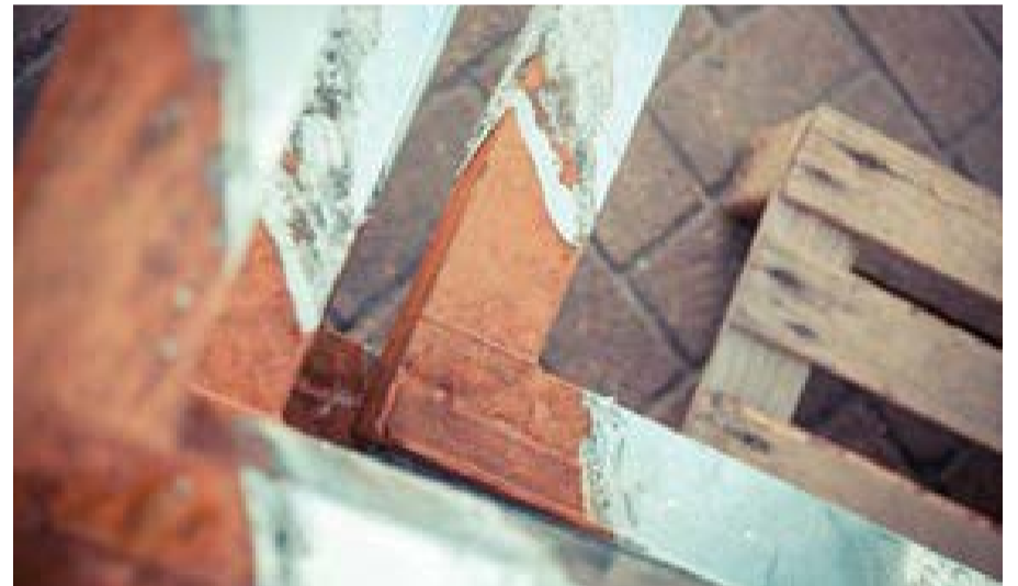
Photo 7 - en raison de l'absence de trous d'aération suffisants, l'objet a flotté.
