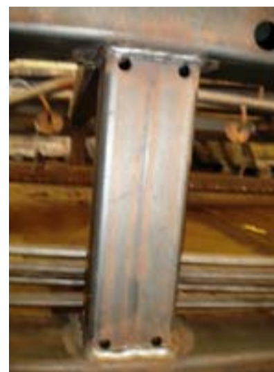
Photo 4 - trous de galvanisation visibles
