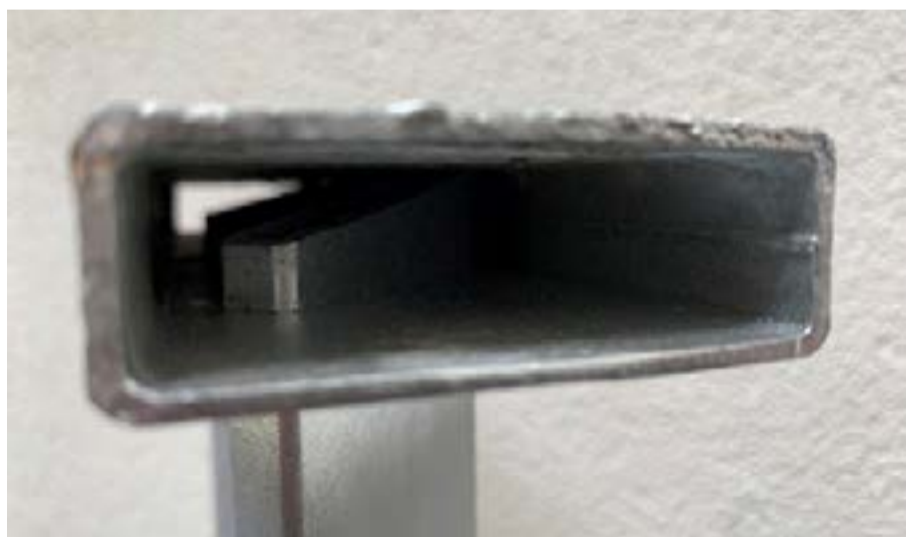
Photo 3 - détail non visible des trous de galvanisation dans le cas d'une clôture à lattes
