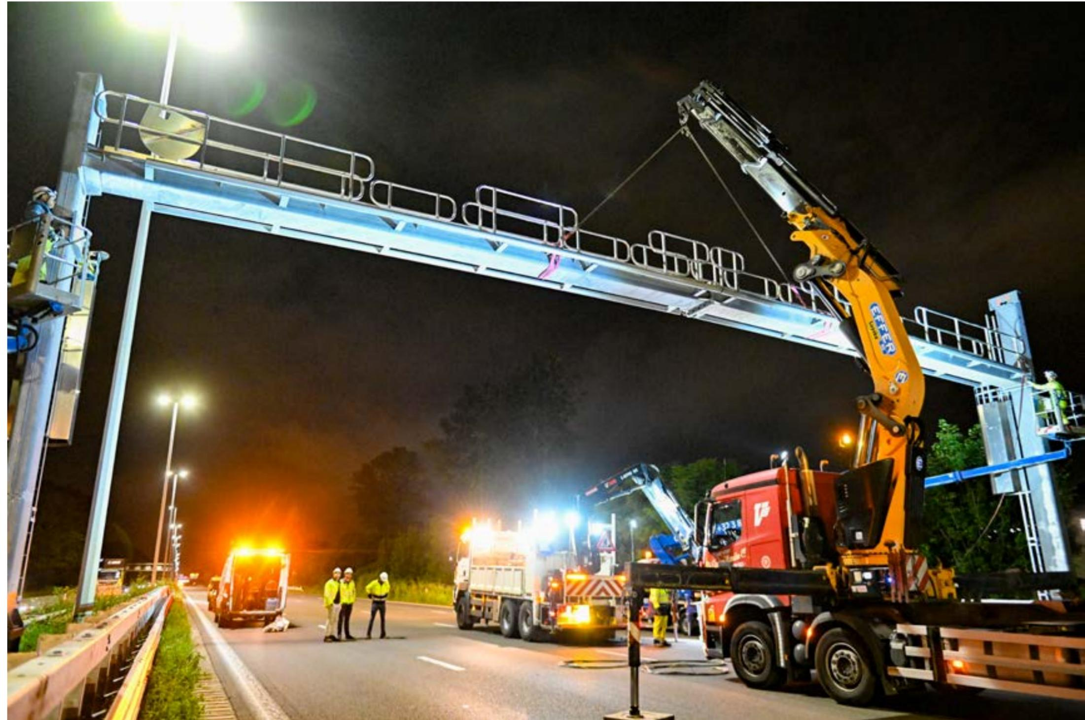
*"Lors du processus de galvanisation, l'intérieur et l'extérieur des profilés du caisson sont protégés par une couche de zinc, ce qui évite tout risque de corrosion interne. Nos portiques sont exposés aux intempéries et au vent tout au long de l'année, et une couche de zinc offre la meilleure protection possible."*
